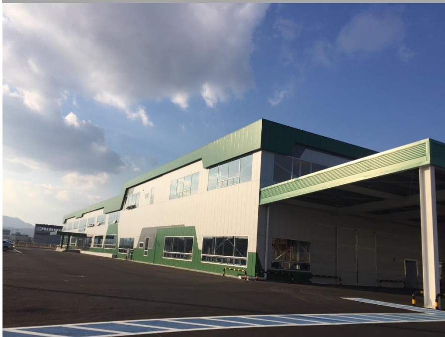
(주)제인모터스, 대구본사(공장) 전경
