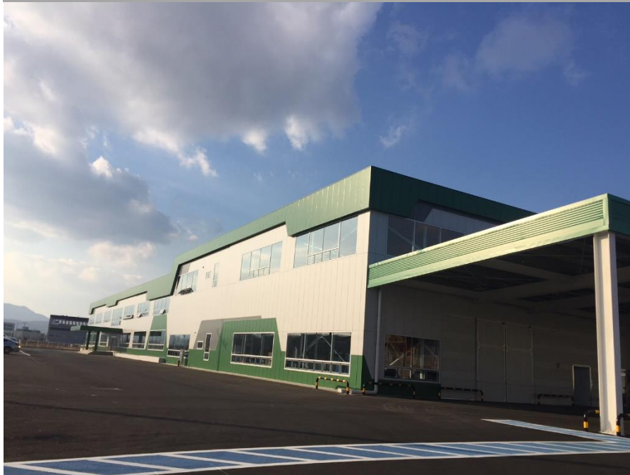
(주)제인모터스, 대구본사(공장) 전경
